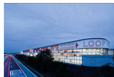
Parkhaus Loop 5, Ansicht A5
